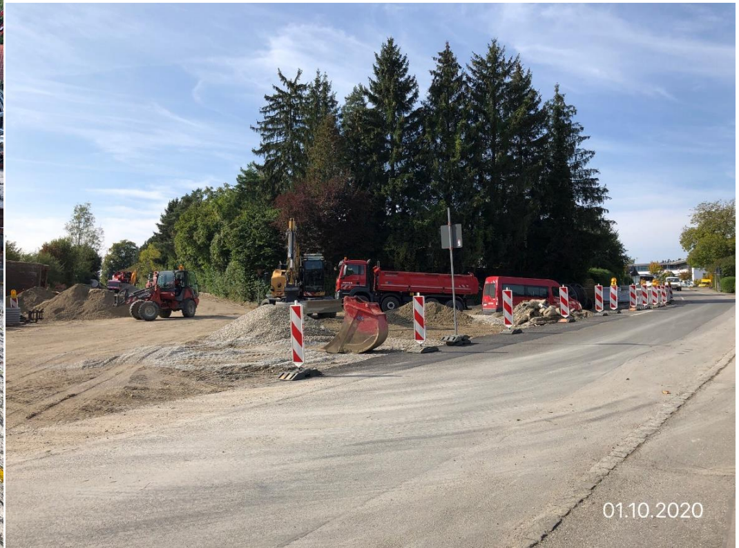
Baustelle Kreuzung Hauptstraße
