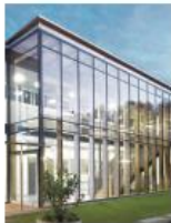
Verbindungsbau Holz-Aluminium Posten-Riegel Konstruktion mit geschlossener 60cm Brüstung
