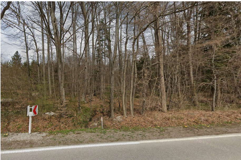
Abbildung 13: Verlauf des Reiserberggrabens südlich des Plangebietes mit Verrohrung St2066
