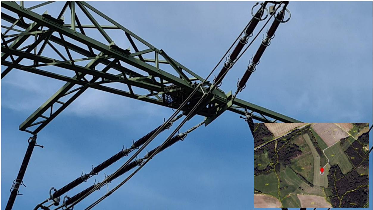
Abb. 11: Besetztes Nest des Kolkraben auf Hochspannungsmast auf dem Grundstück Fl. Nr. 2470 am 06.05.2024.
