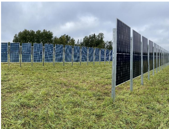
Abbildung 4: vertikale Agri PV-Anlage exemplarisch, Next2Sun
