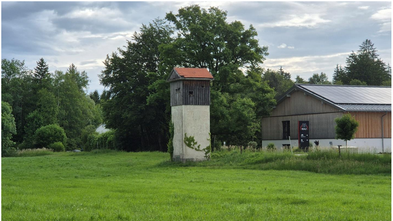
Abb. 5: Das ehemalige Trafohäuschen auf dem Grundstück Fl. Nr. 2718/1 am 02.06.2025.
