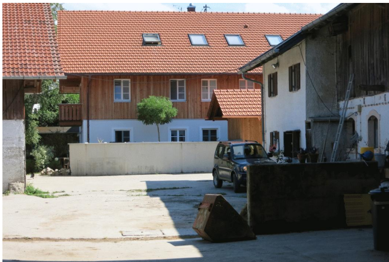
Abb. 11 Wichtige Raumkante, teilweise funktionslosen Freiflächen; im Hintergrund ein gelungener Ersatzbau
